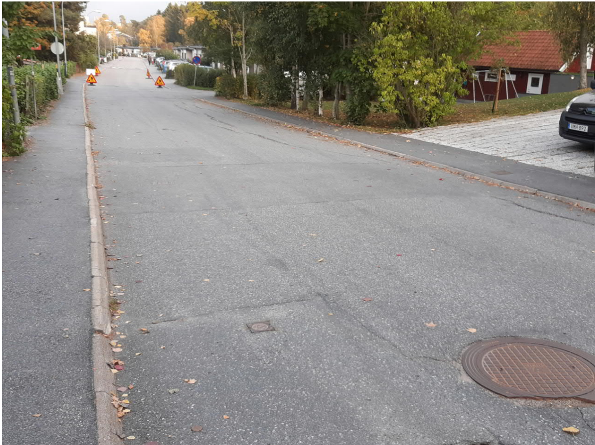
Figur 10-3 Sprickor asfalt utanför rörgrav, Mossvägen väster om Björnmossevägen med korsning synlig i förgrunden. Notera uppfyllnad för infart Mossvägen 125 t.h. i bild.
