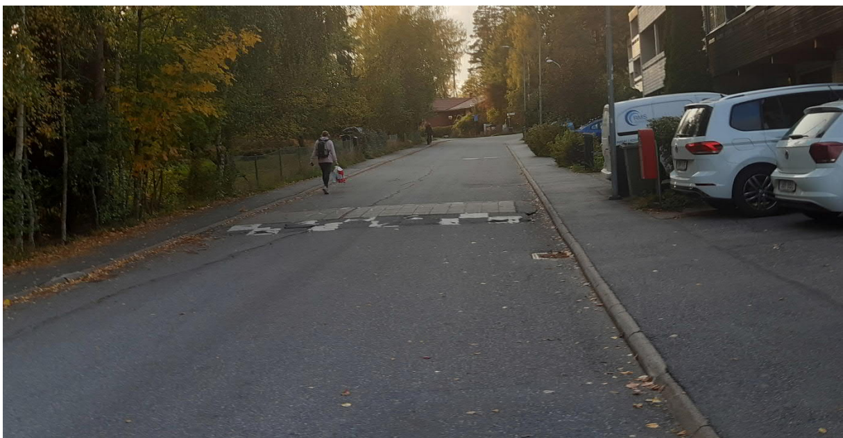
Figur 10-2 Sprickor asfalt utanför rörgrav, Mossvägen väster om Björnmossevägen.
