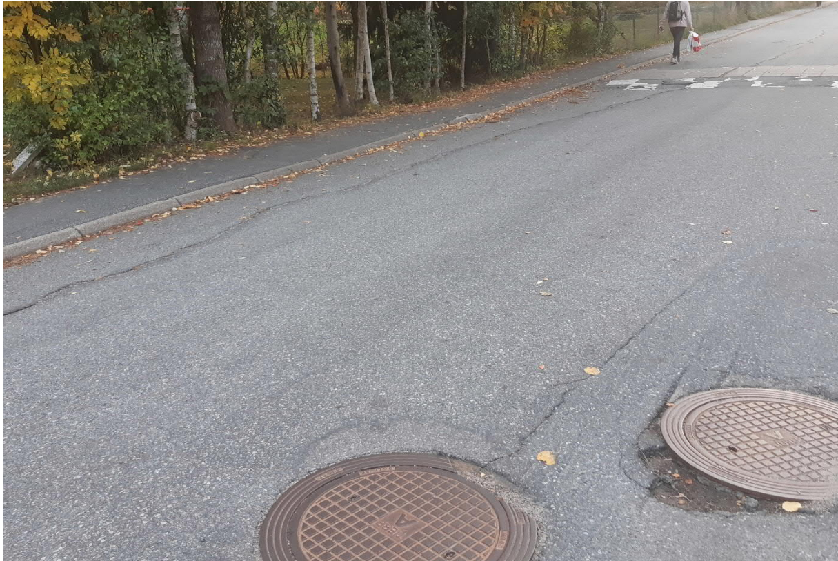
Figur 10-1 Sprickor asfalt utanför rörgrav, Mossvägen väster om Björnmossevägen.
